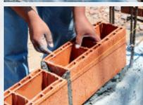
4. Instale nuestros productos con mortero cemento-arena en proporción 1:5. Para boquillas más claras o reducir álcalis y así evitar el salitre recomendamos el uso de "cemento de albañilería" en proporción de 1:5.
