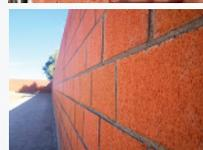
9. Si al muro no se le dará acabado aconsejamos rociar con aspersor un sellador recomendado para barro para que no se filtre humedad por las boquillas. Si se va a recubrir el muro con yeso o estuco humedecer el muro antes de colocar los empastados.
